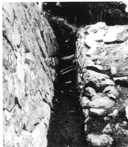
3号石垣北側側溝
