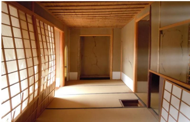
軸組がゆがみ、壁にひびが入った本丸御殿内部(数寄屋棟)
