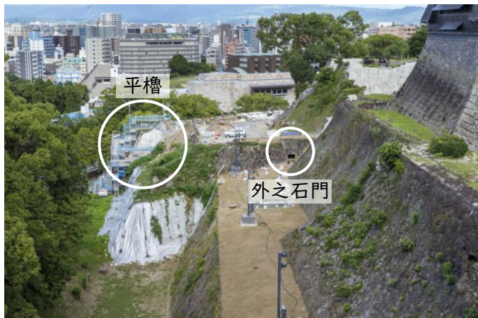
宇土櫓素屋根からの景色（令和6年〔2024年〕7月）
