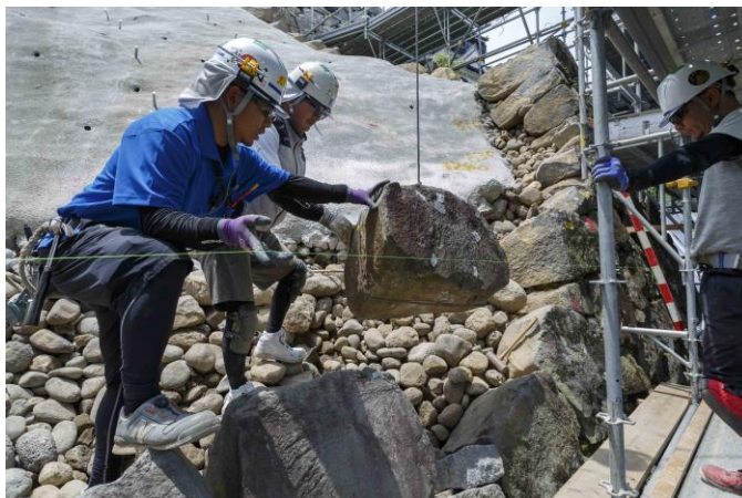
平櫓下石垣の積み直し作業（令和6年〔2024年〕6月）
