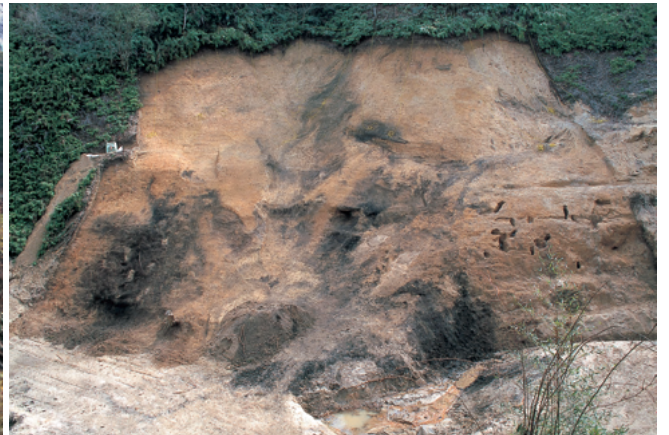
(20) 70地点検出状況（北西から）
