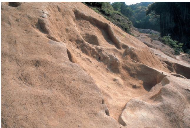
(80) 70地点 SX02全景（北から）
