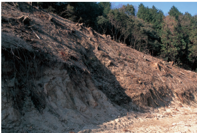
(107) 72地点調査前（南から）
