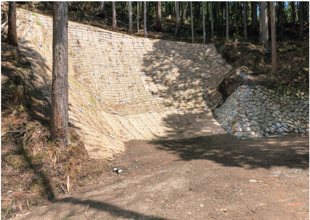
2 第5調査地点付近復旧状況（南西から）
