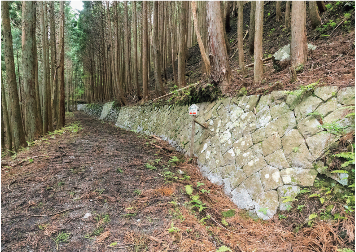
1 第2調査地点現況（東から）
