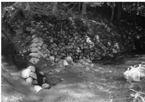
写真8 TT5と法面石垣（西から）
