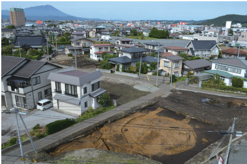
第3次調査 I・II区 (南から)
