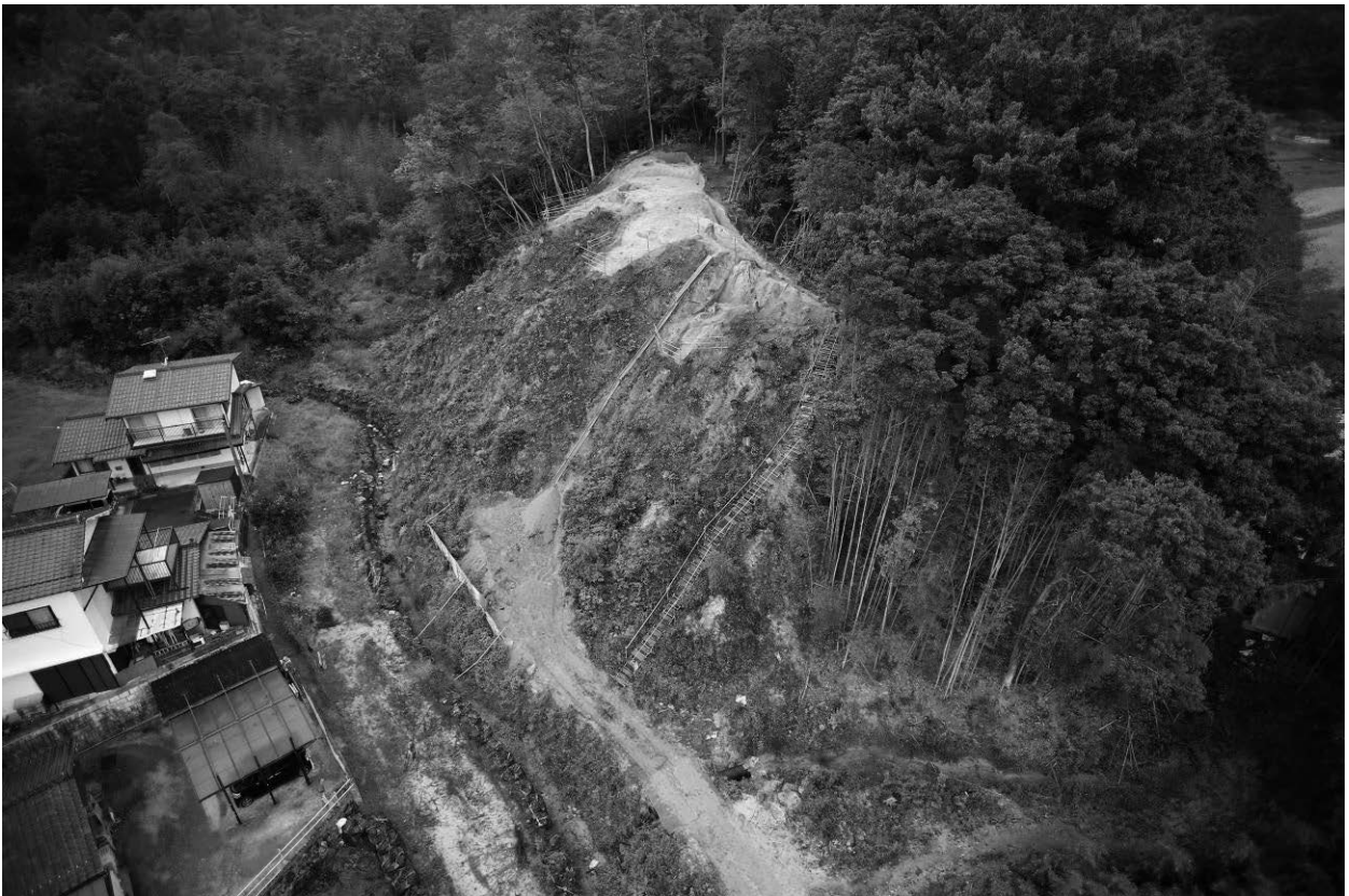
b. 完掘（南側上空から）
