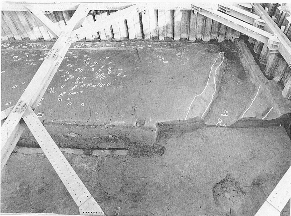
Cトレンチ南端全景(西から)
