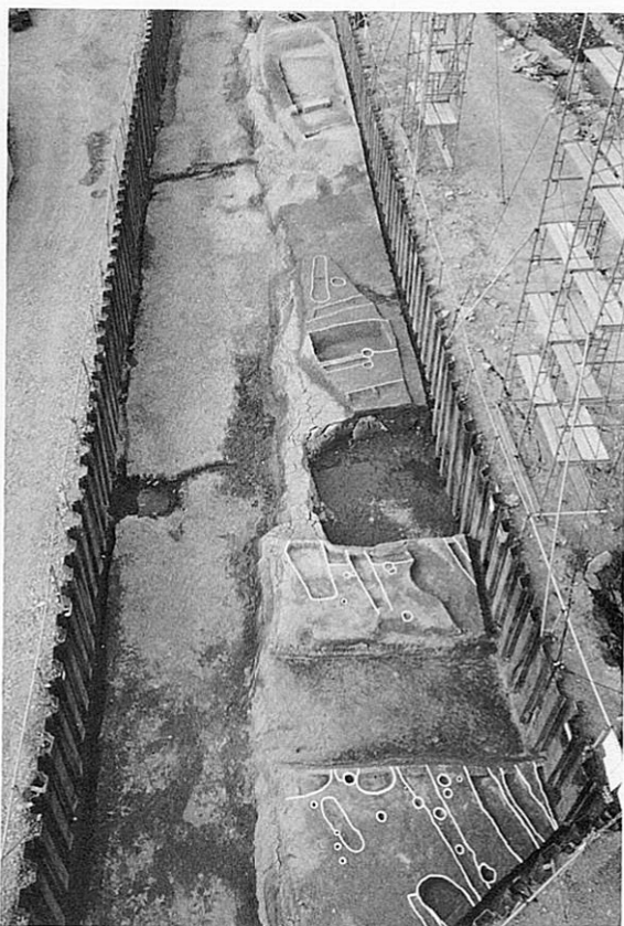
Bトレンチ全景(南から)
