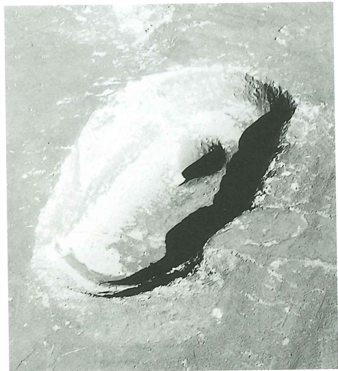
第1号土壇 東から
