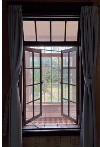
写真3 応接室の観音開きの窓
