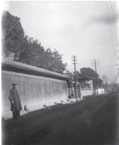
写真1 新道 岡田善蔵宅の南側附近
