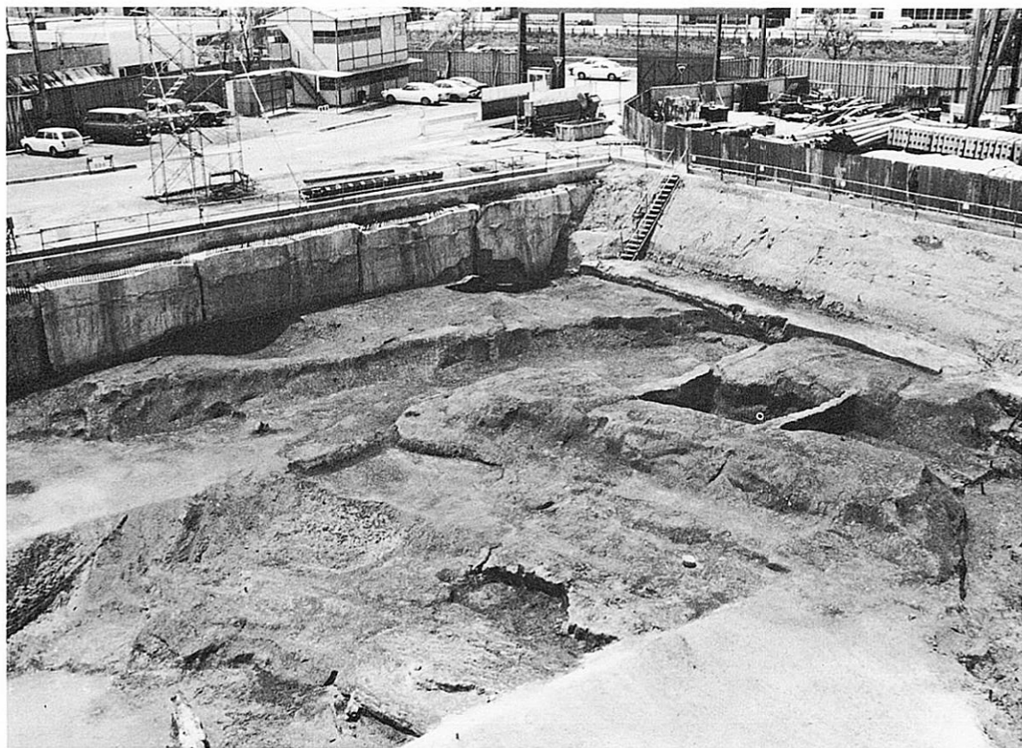
E~J-8~13区 全景 (北東から)
