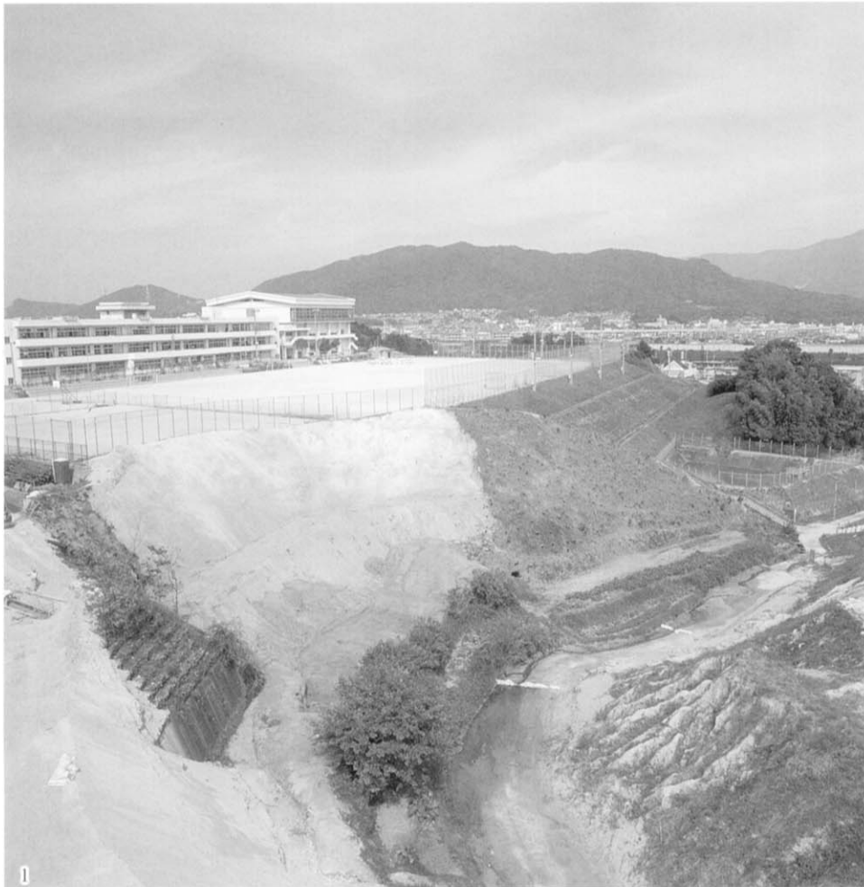
1 第10次調査区全景（西から）
