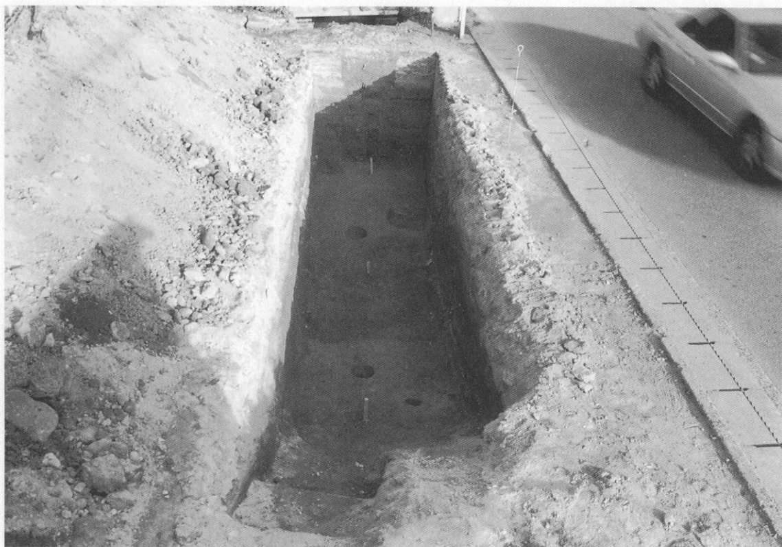
2-1区完掘状況 (西より)
