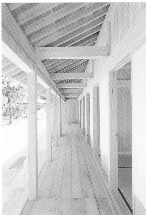
8. 竣工 廊下 (西側より見る)
