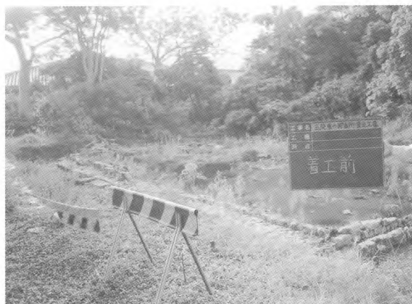
11. 工事着手前 (北東側より)
