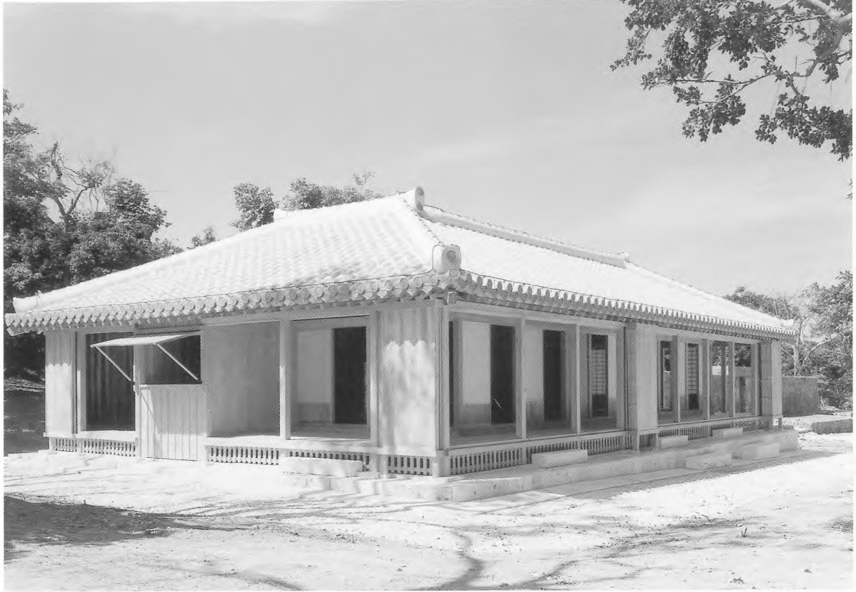
3. 竣工 北東側より見る
