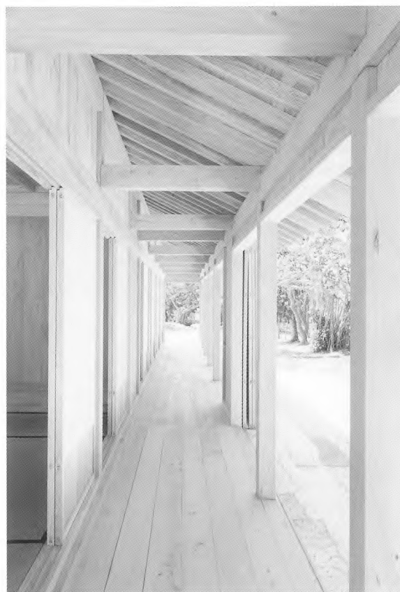
9. 竣工 廊下 (東側より見る)
