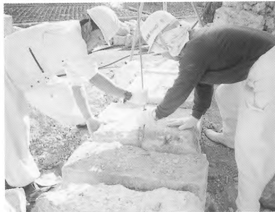
8. 排水孔蓋石設置
