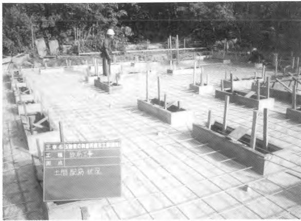
22. 土間鉄筋配置 (北東側より)
