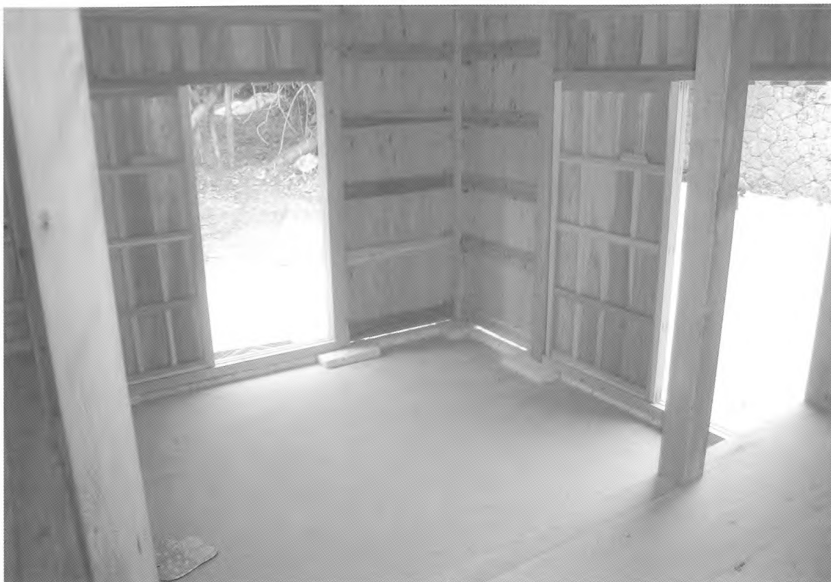
7. 竣工 台所土間
