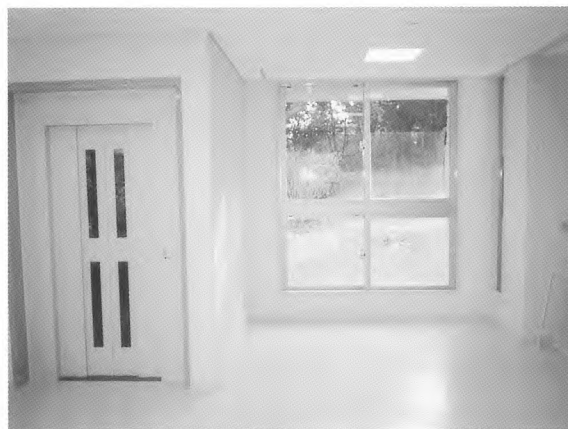
5. 1階ホール (西側より)
