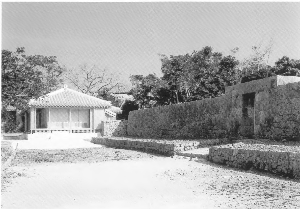
1. 竣工 西方より見る
