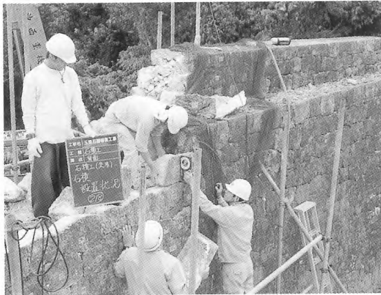
7. 石積設置 (背面)
