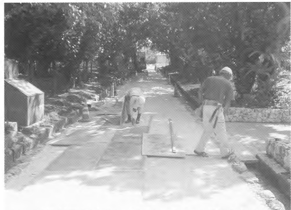
21. 既設舗装撤去後、仮設通路設置（奉円館前）
