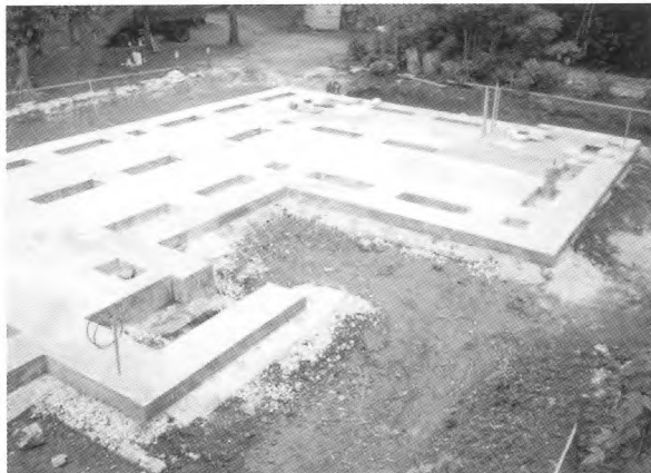
23. 土間コンクリート打設後 (南西側より)
