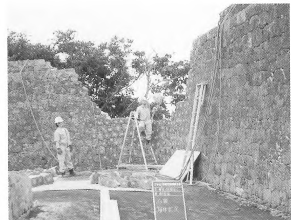
4. 石積解体 (背面)
