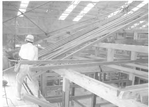
45. 垂木取付（東面）
