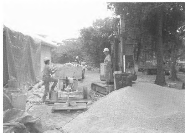
22. 舗装材配合状況
