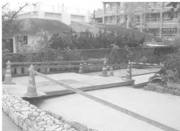
26. 養生期間中の仮設通路（奉円館前）
