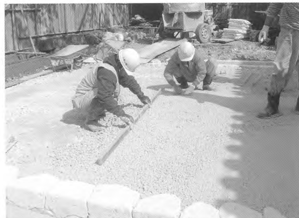
88. 透水性舗装 (参詣道スロープ)
