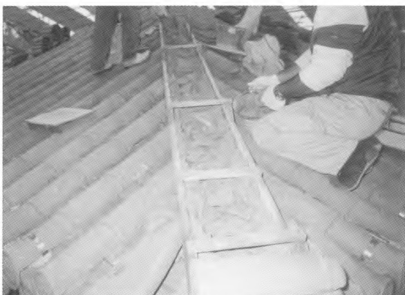
79. 隅棟（碎瓦と葺土を詰め、その上に平瓦を重ねる）
