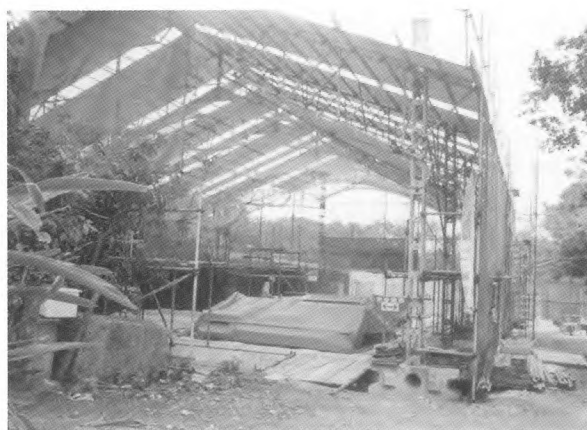
16. 素屋根完成 (東側より)
