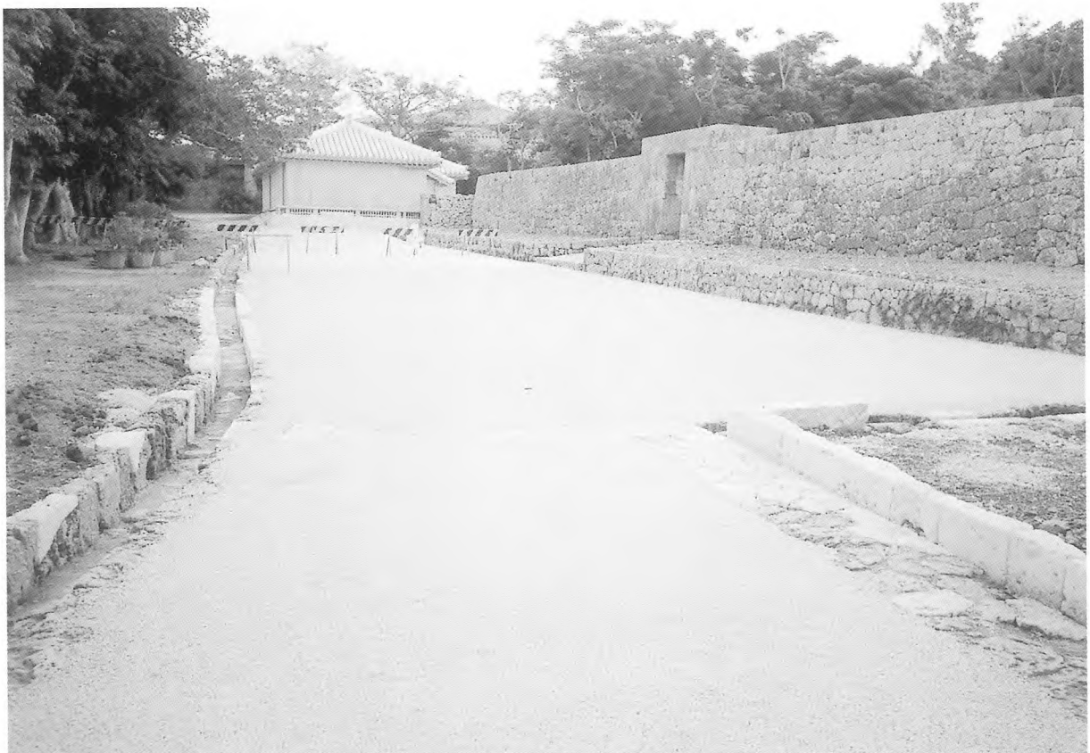
2. 竣工 西の御番所跡前より東方を見る
