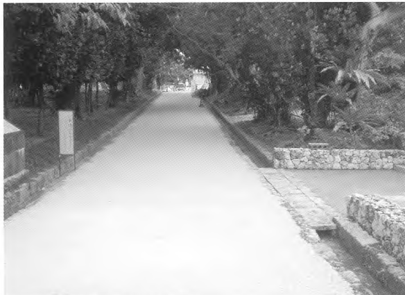
25. 舗装完了（奉円館前）
