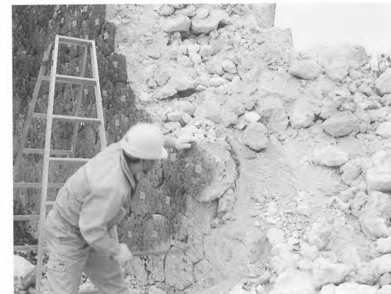
5. 石積解体 (前面左側)
