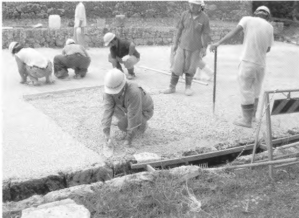
24. 舗装状況（第一門前）
