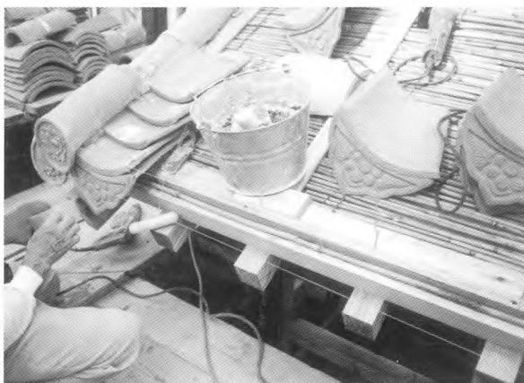
75. 軒先瓦葺き（瓦座には亜鉛釘に銅線を巻き付け）
