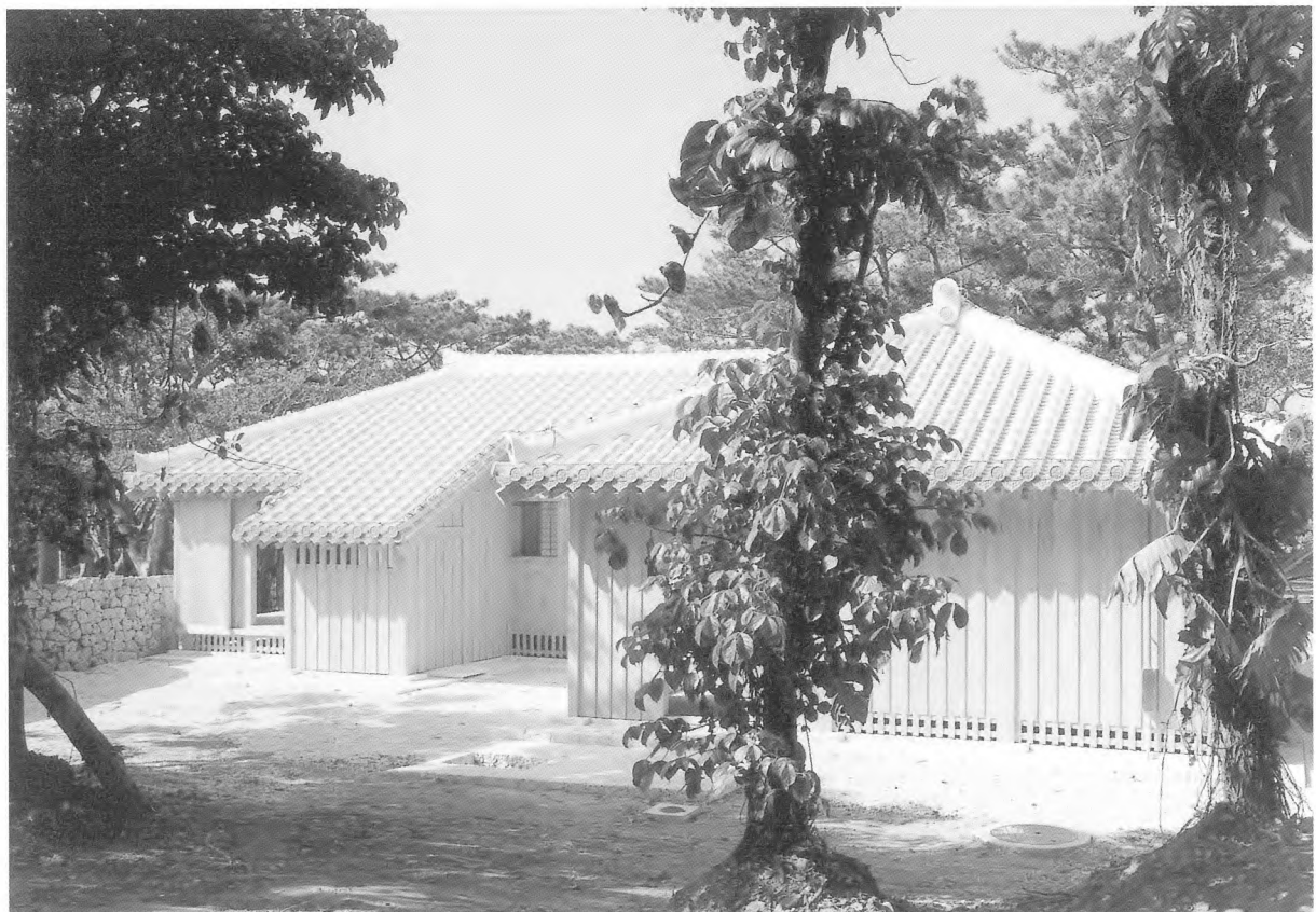
4. 竣工 南側より見る
