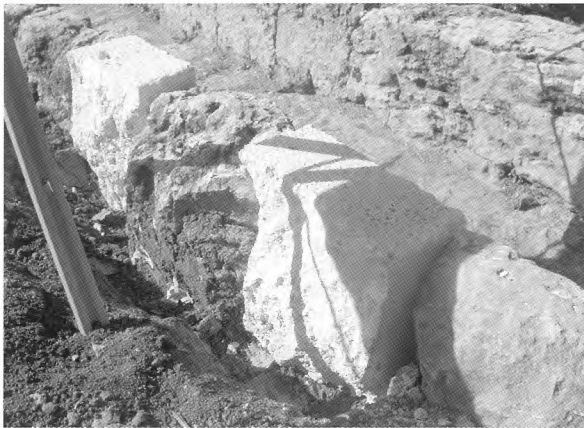
16. 排水溝設置 (欠損箇所 控え)
