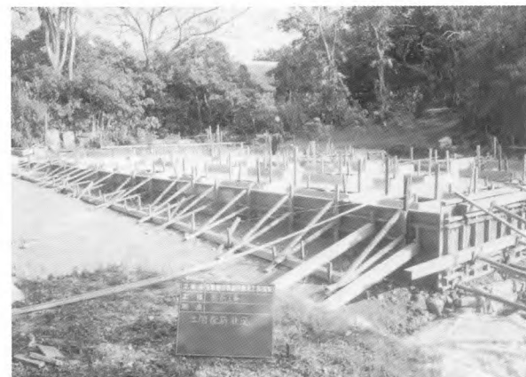
21. 土間型枠設置 (北西側より)
