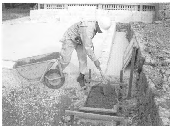
27. 説明板基礎設置 (コンクリート打設)
