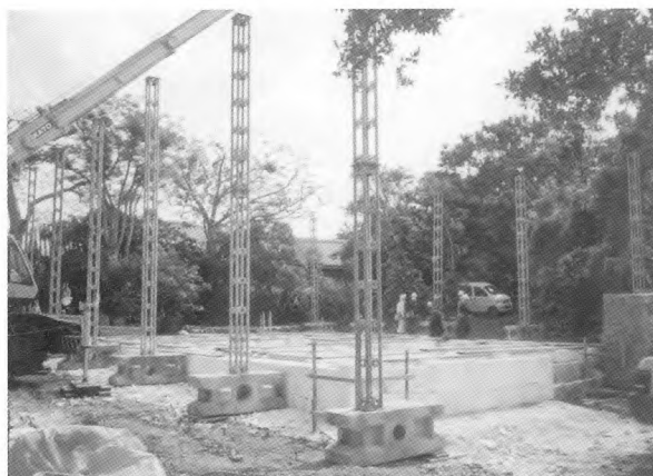
15. 素屋根建設 (北西側より)
