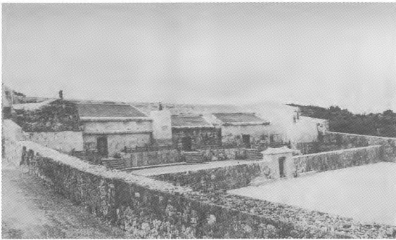
修理後 墓室方向を見る
