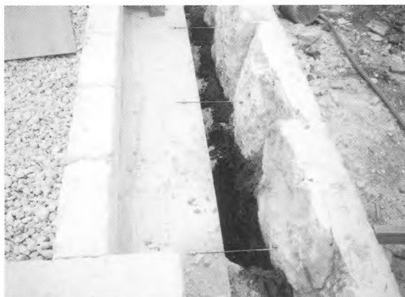
28. 倒れ防止アンカーボルト (基壇部分)
