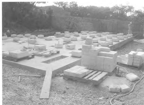
25. 礎石据付 (北東側より)
