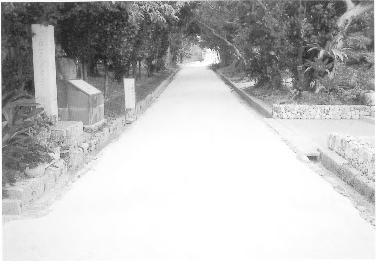
1. 竣工 奉円館前より東方を見る
