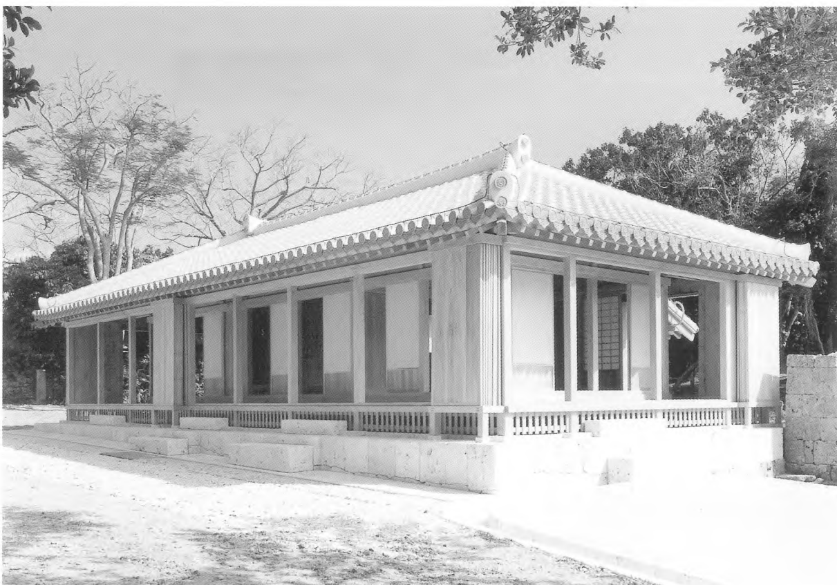
2. 竣工 北西側より見る
