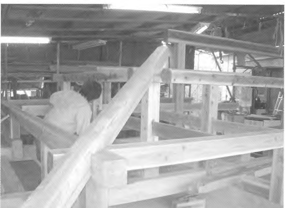
37. 小屋仮組み (同上)
