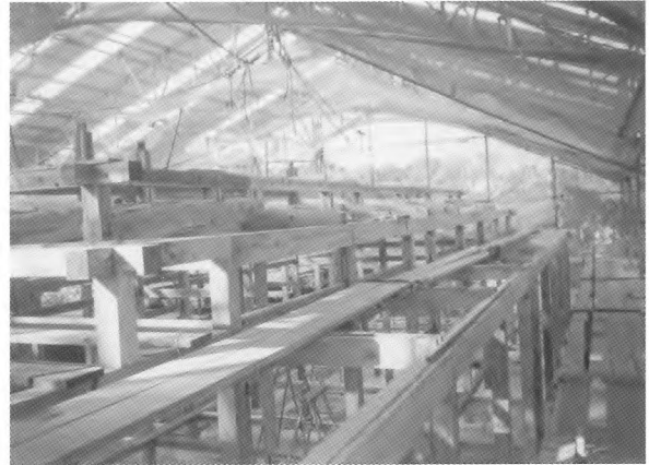
43. 小屋組（北東側より）
