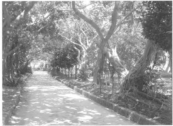
19. 既設舗装撤去前（西の御番所跡前より西方）
