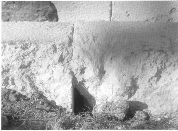
15. 排水溝設置 (接着剤補強)
