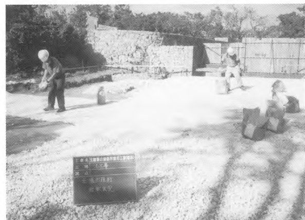
20. 土壌処理剤散布 (東側より)
