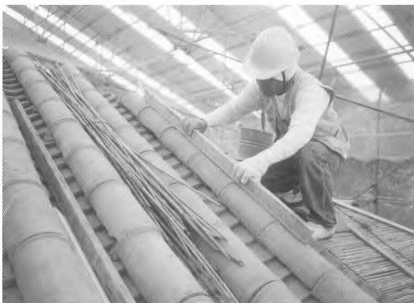
77. 丸瓦葺き（定規にて通りを出す）
