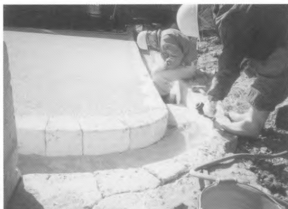
32. 側溝石敷き (参詣道スロープ北側)
