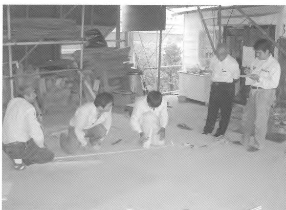
35. 原寸検査：墨打ち (同上)
