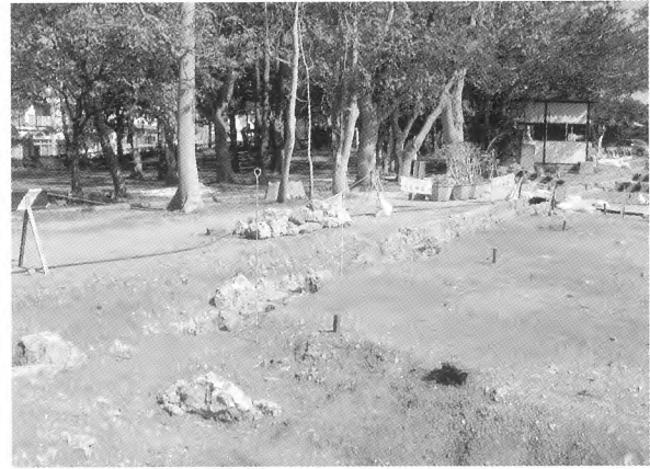
5. 石組排水溝（欠損箇所）
