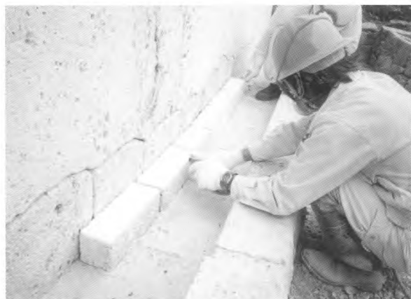
33. 踏石支石設置 (西面側溝)
