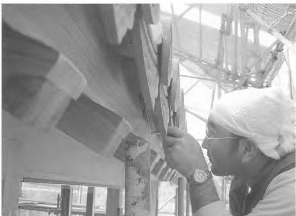
81. 瓦座処理（軒平瓦と瓦座の隙間・瓦座表面を漆喰で仕上げる）
