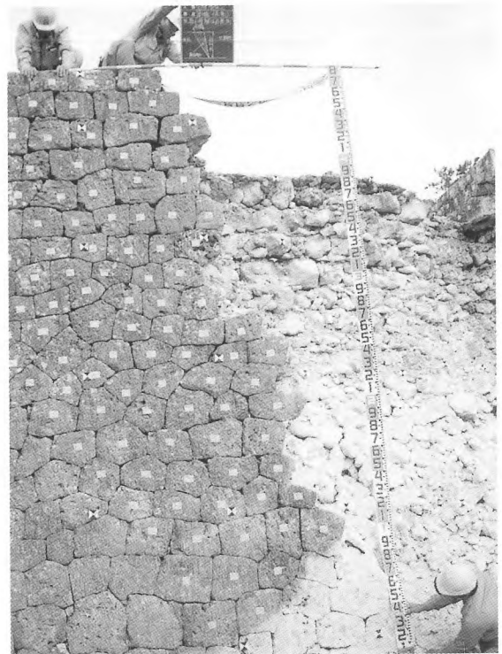
3. 解体前検測 (前面左側)
