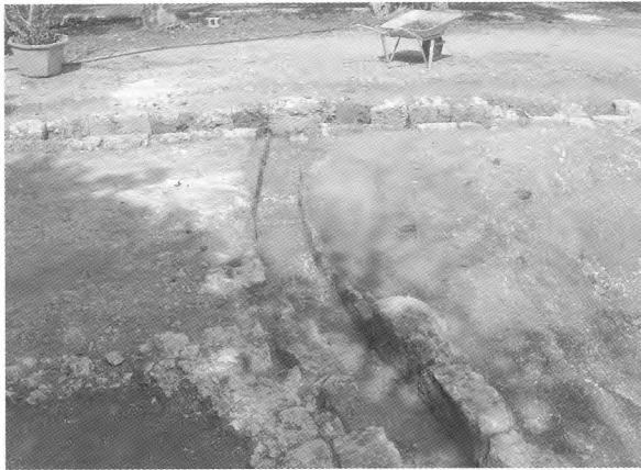
8. 暗渠蓋除去後（西の御番所跡前）
