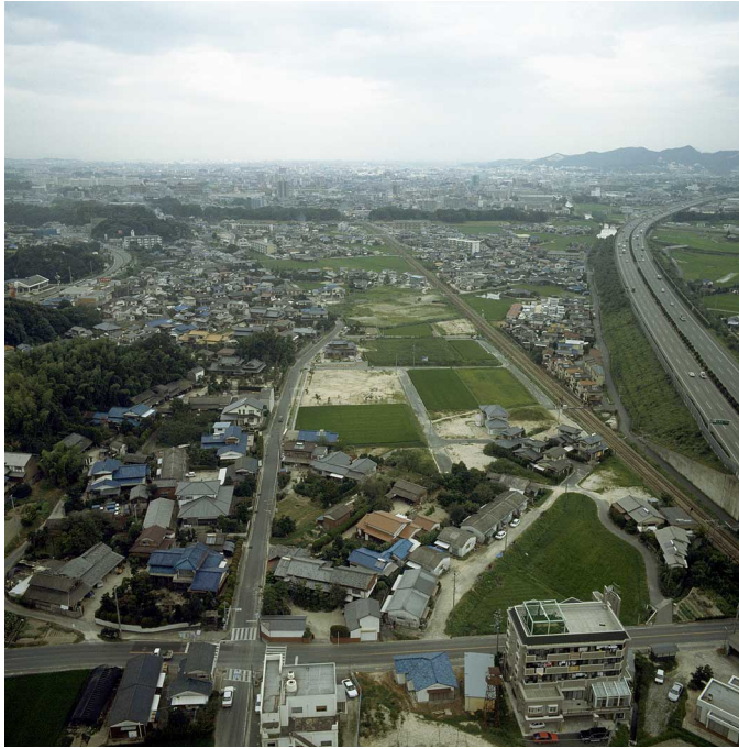
調査地から水城跡を望む（上が北）
