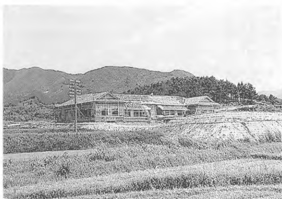
Fig. 2 本館移築完成間近（昭和15年9月）
