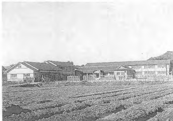
Fig. 3 第一期工事竣工（昭和17年3月）
