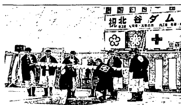
北谷ダム定礎式で地入れされた礎石の据え付け作業をする企業体関係員
