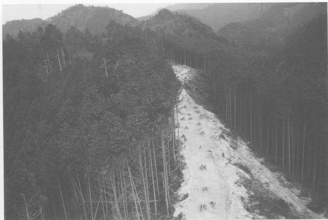
2 14次調査全景（北東より）
