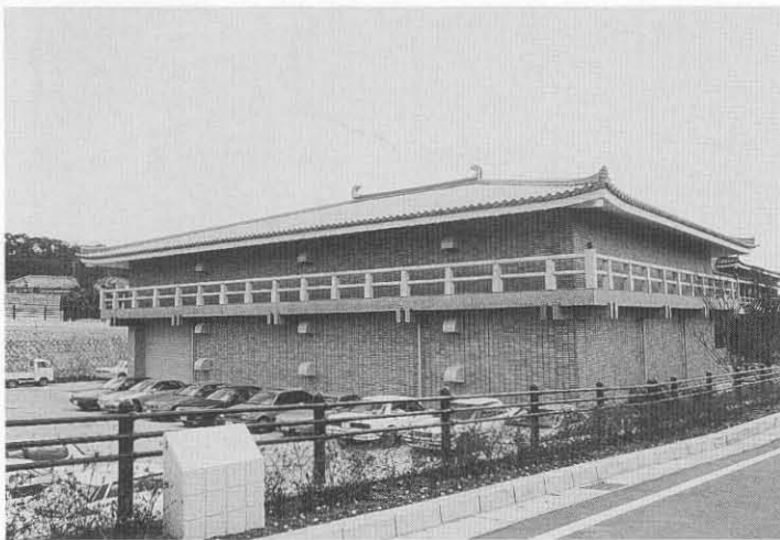
第56図 収蔵庫の屋根と説明板 (写真左下)
