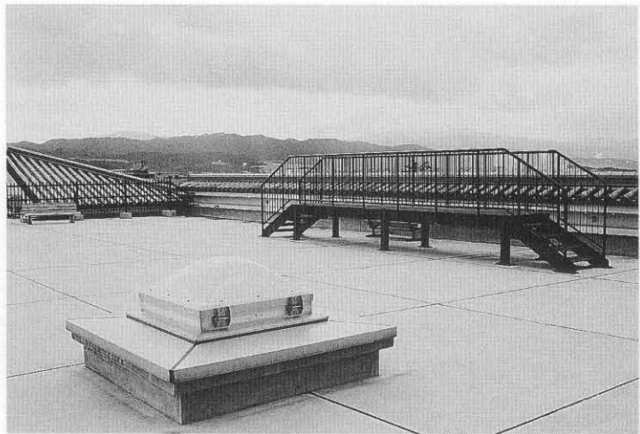
第54図 屋上（追加設置した見学台）
