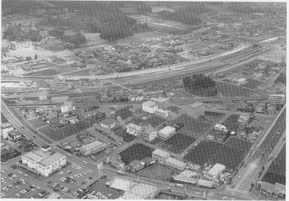
条106次調査区および政庁跡（西から）
