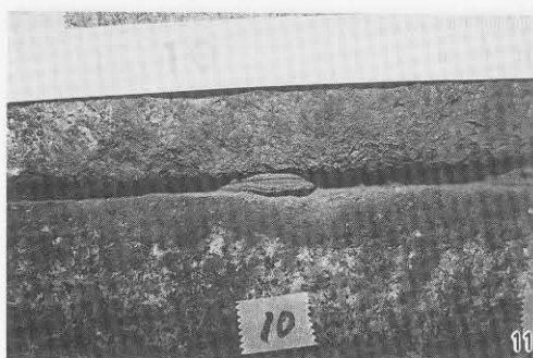
石柱銭変形状況
