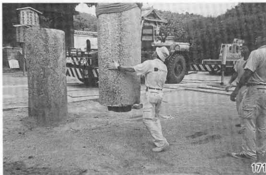
右柱除去状況
