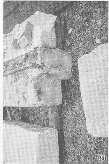
右柱木接合部
