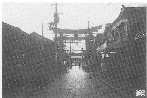
撤去前東より
