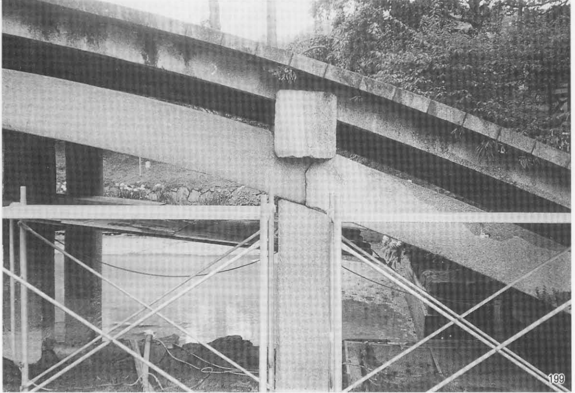
三の橋 橋脚部分
