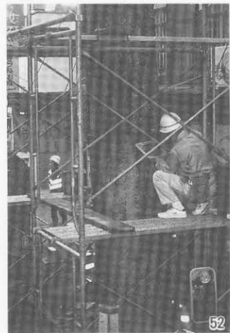
左柱コンクリート補填
