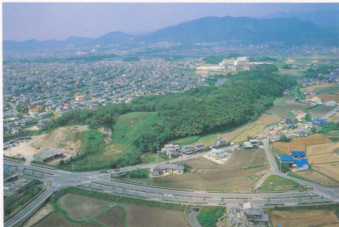
調査開始前の宮ノ本遺跡（南西から）
