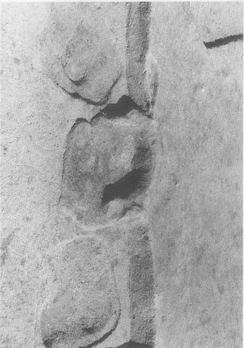
1S1030 覆換出状況
