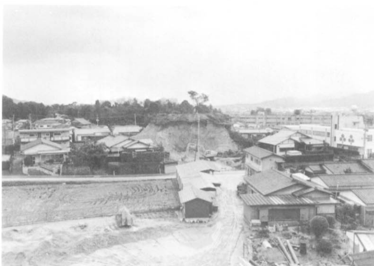
I 6 AYP 地域遠景 (北西から)
