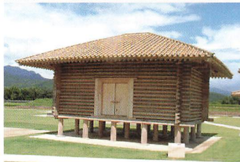
■上：20号建物跡、下：20号建物跡を復元した米倉 鞠智城Ⅳ期の建物で、3間（7.2m）×4間（9.6m）の礎石建物です。この時期には、同規格の建物が規則正しく配置されています。
