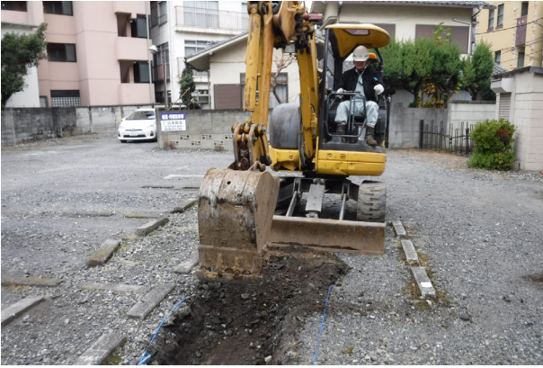
写真 83 表土掘削作業風景（南から）
