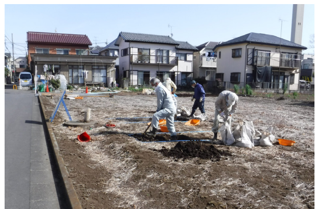
写真 97 作業風景 (南から)
