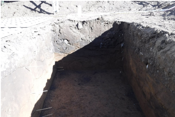
写真 34 調査区東壁土層堆積状況（西から）
