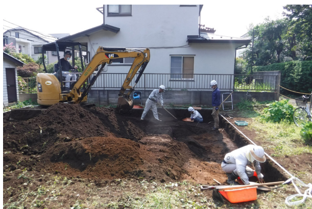
写真23 表土掘削風景(西から)
