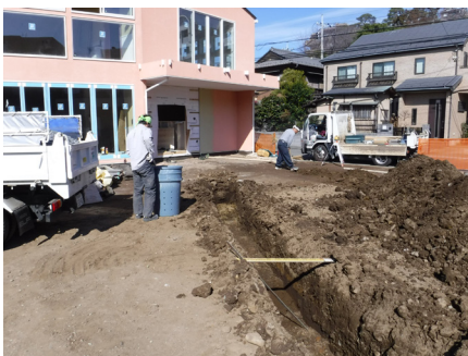
写真 6 No. 105 立会状況 (▲より)
