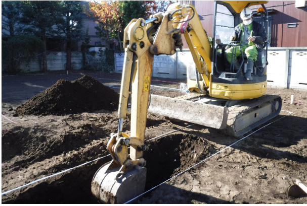
写真 33 表土掘削風景（東から）
