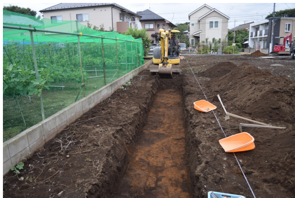
写真15 遺構検出状況（東から）
