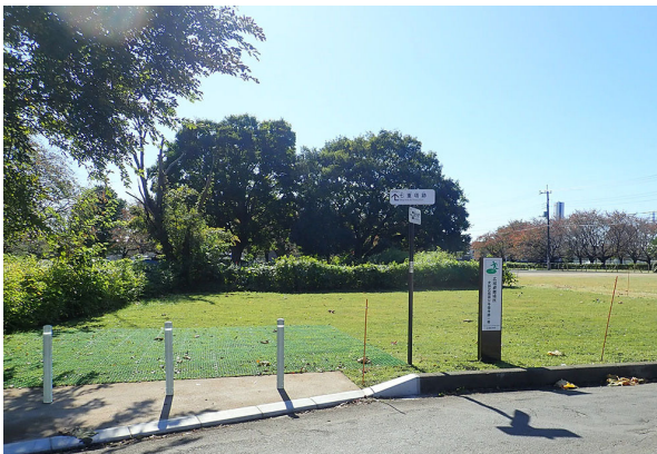
写真1 中門東側の施工状況
