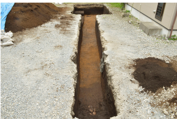
写真19 調査地点全景（北から）
