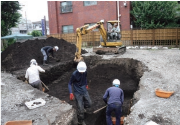
写真10 表土機械掘削作業（南東から）
