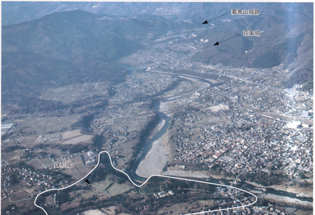
要害山城跡遠景（寄居市街から）
