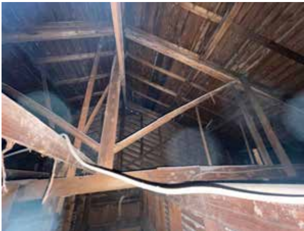
写真3 米軍ハウス④の小屋組
