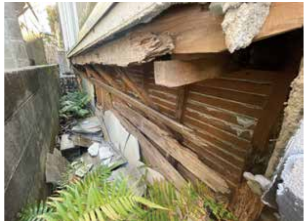
写真4 米軍ハウス④の外壁下地
