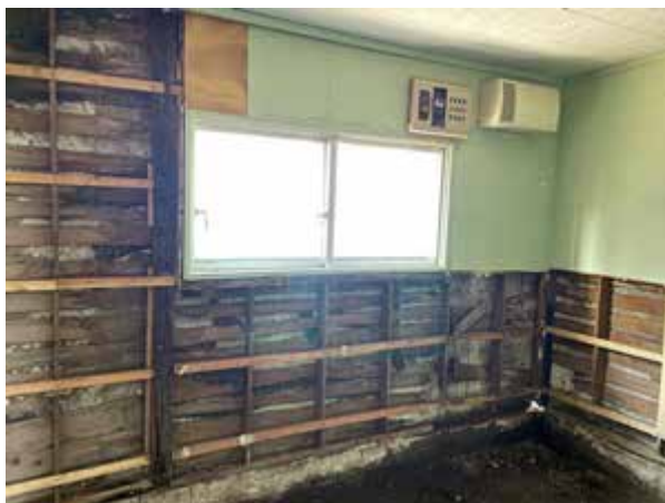
写真7 瑞穂町の米軍ハウス外壁下地裏
