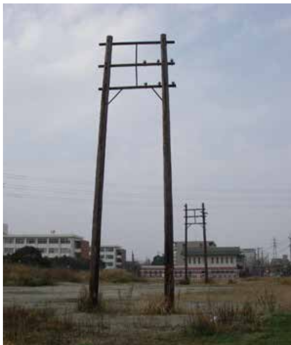
写真 46 木製鳥居型電柱 (手前 73、奥 74)
