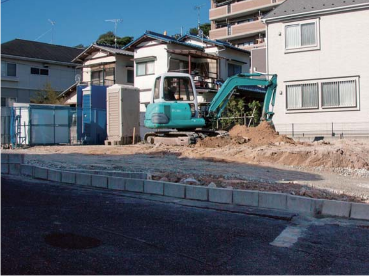
(1) 調査前風景 (南東より)
