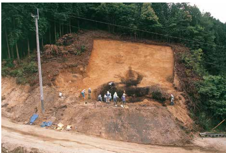
(3) D地点5号窯跡 作業風景(北東から)
