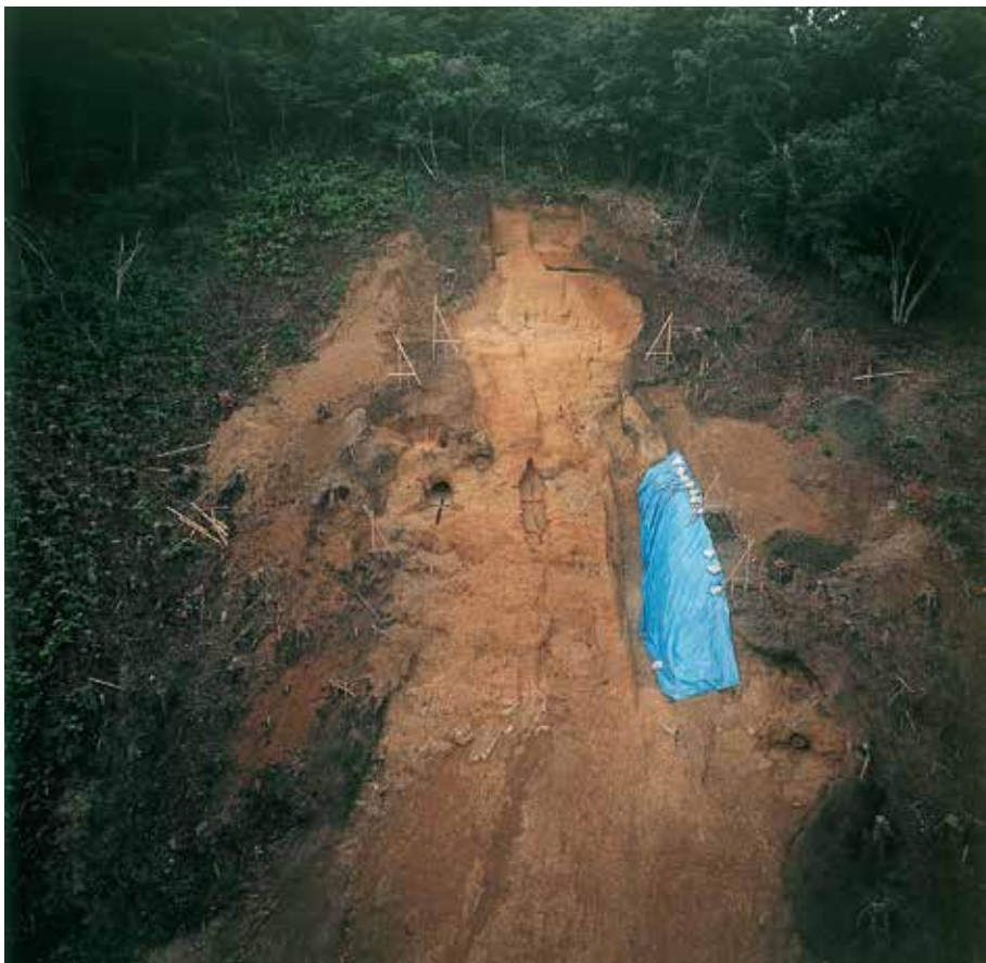
(2) F地点全景（東から）
