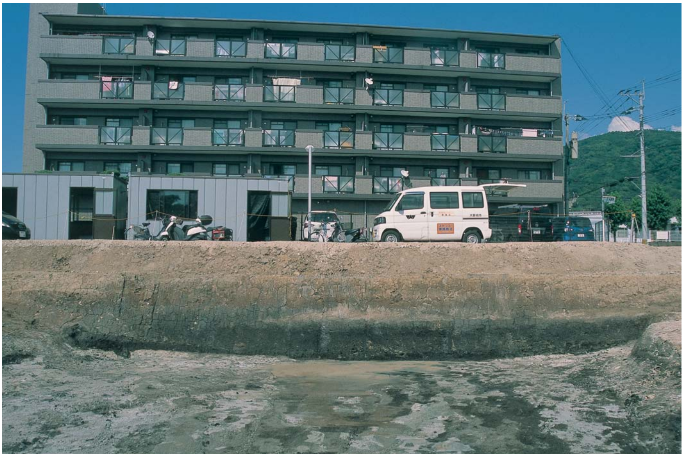
(2) 調査区東壁土層（南西から）
