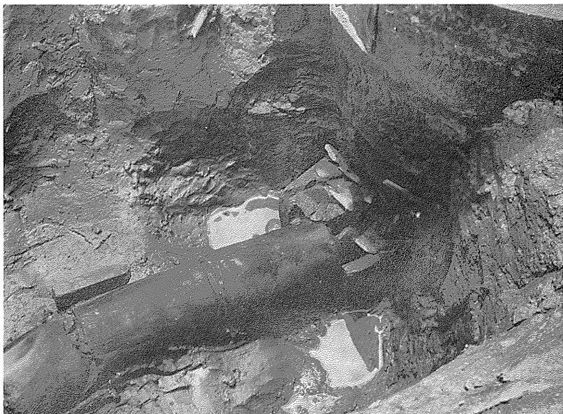
同導水管接合状況（北から）
