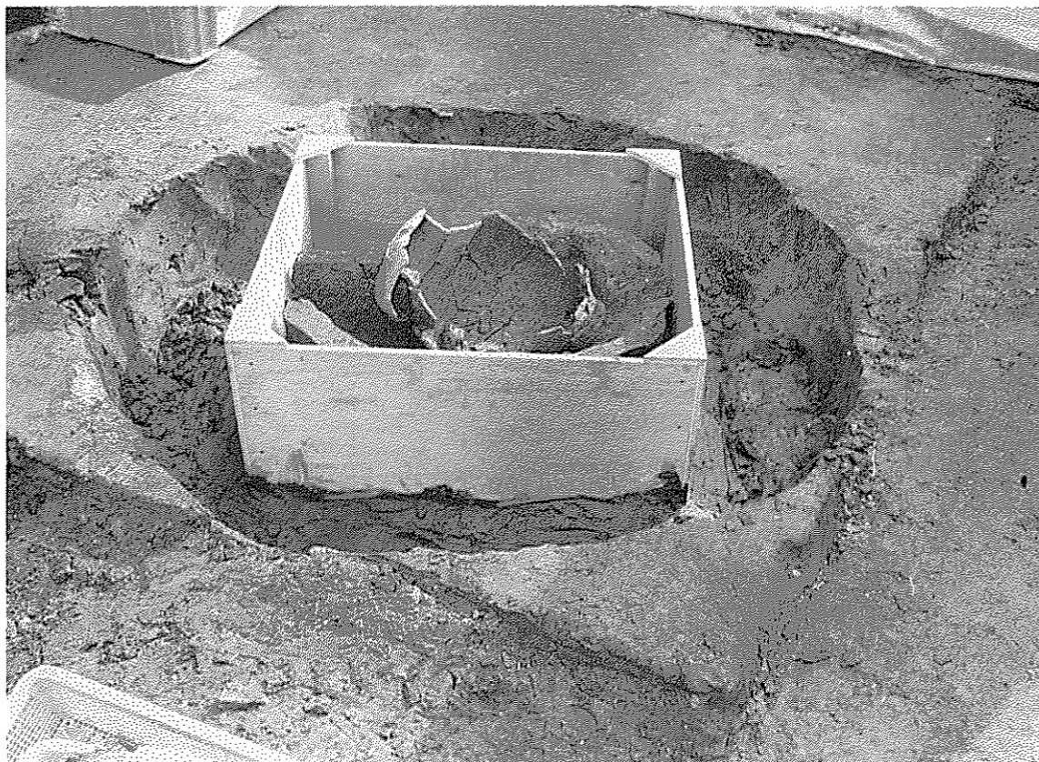
木枠組み状況
