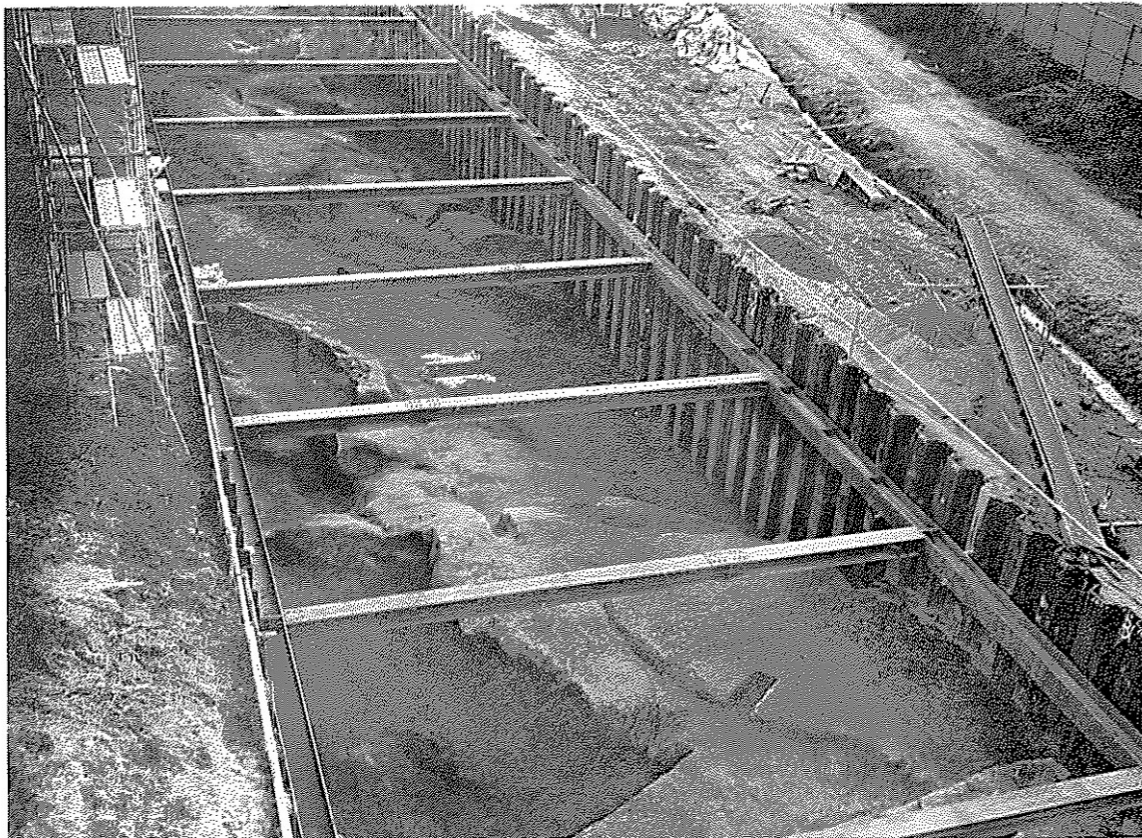
NR 3003 全景（北東から）
