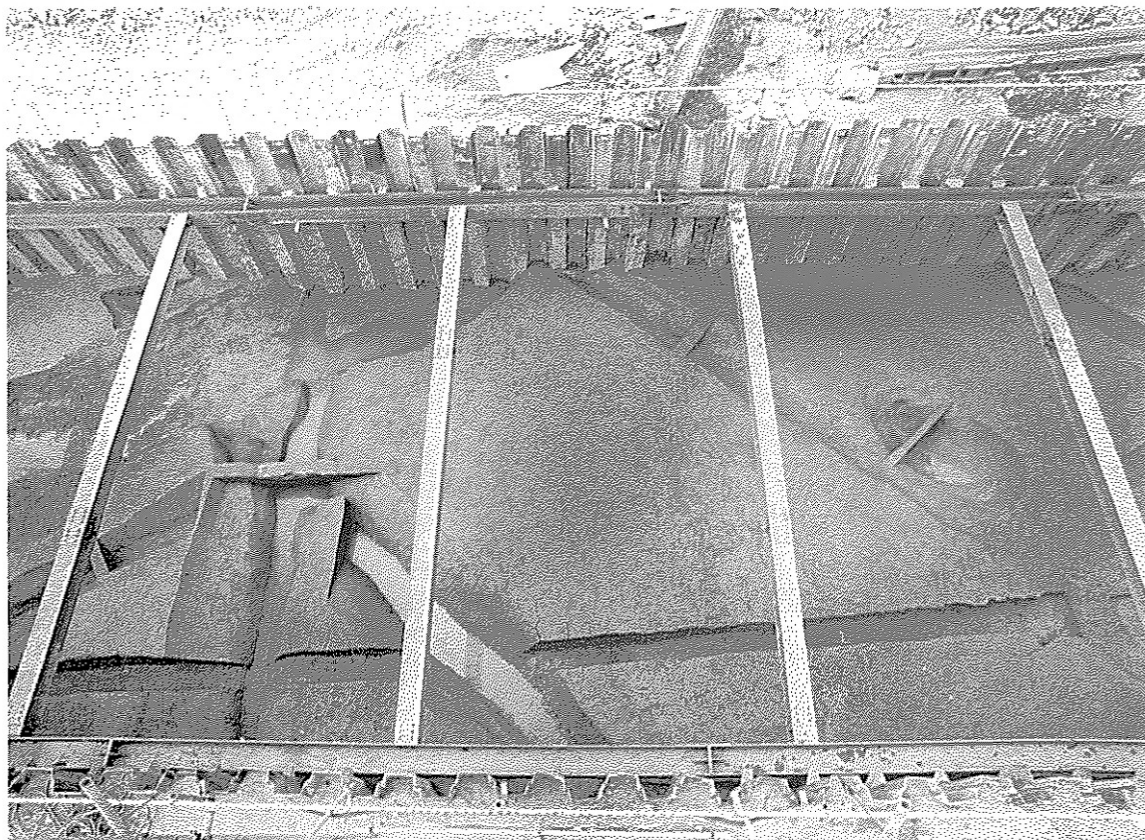
-7~-3ライン区層上面(東から)
