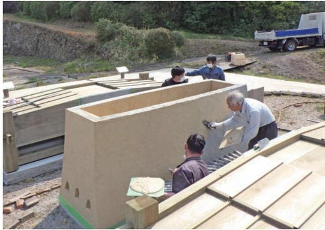
製鉄炉復元製作状況 (2) (珪藻土仕上げ)
