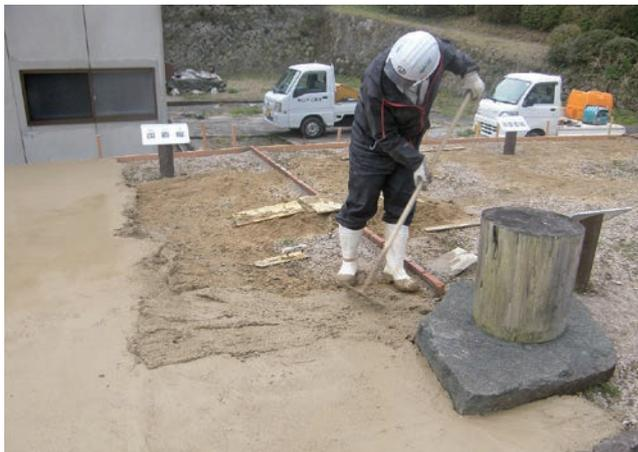
真砂土舗装施工状況（西から）
