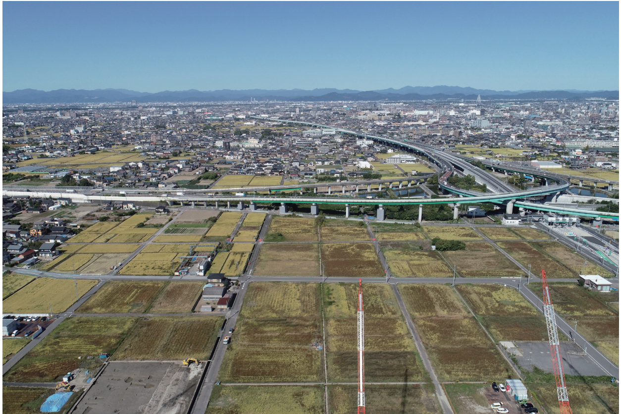
1. 1工区 西半部 調査区北部 (上が北)
