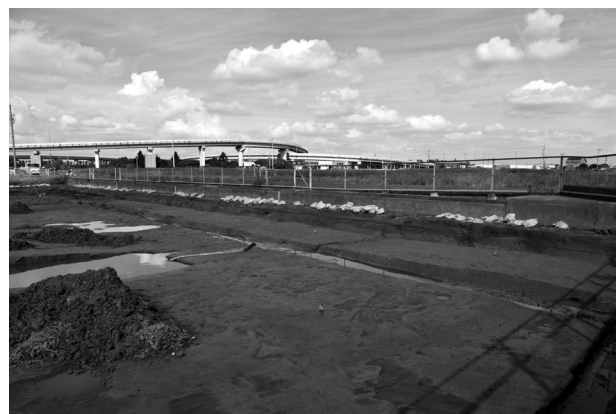
4. 1工区 調査区 土層断面状況 (南西から)
