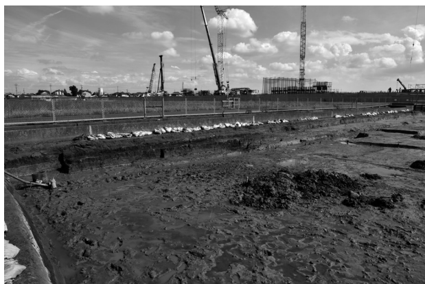
3. 1工区 調査区 土層断面状況 (北西から)
