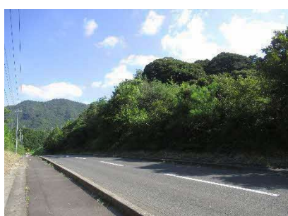
㉔市道杉沢線側の法面
