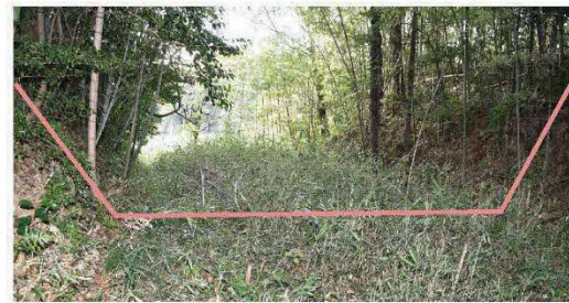
切通しの状況（西から）
