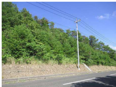
①市道杉沢線側の法面
