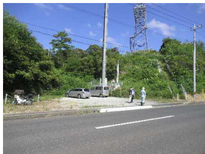
②鉄塔管理用平坦部
