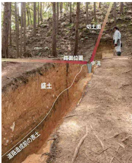
盛土の状況（杉沢遺跡 北から）
