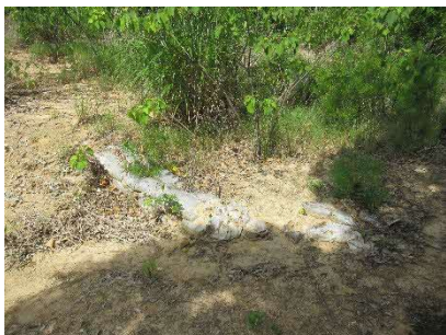
⑭仮設土留め
