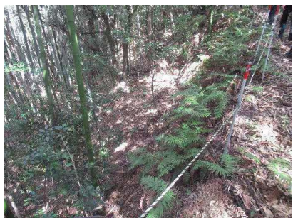
⑯急傾斜部の危険箇所
