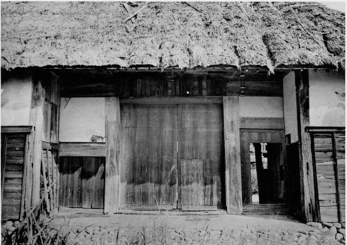
21 修理前 長屋通り
