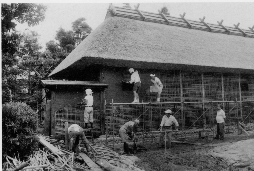
67 壁工事 (荒壁塗)
