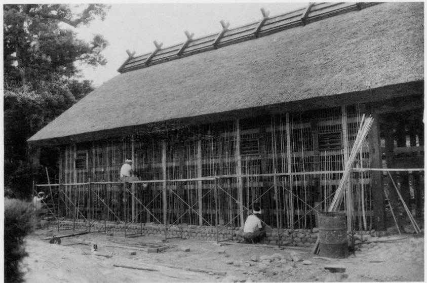
66 壁工事 (小舞掻き)
