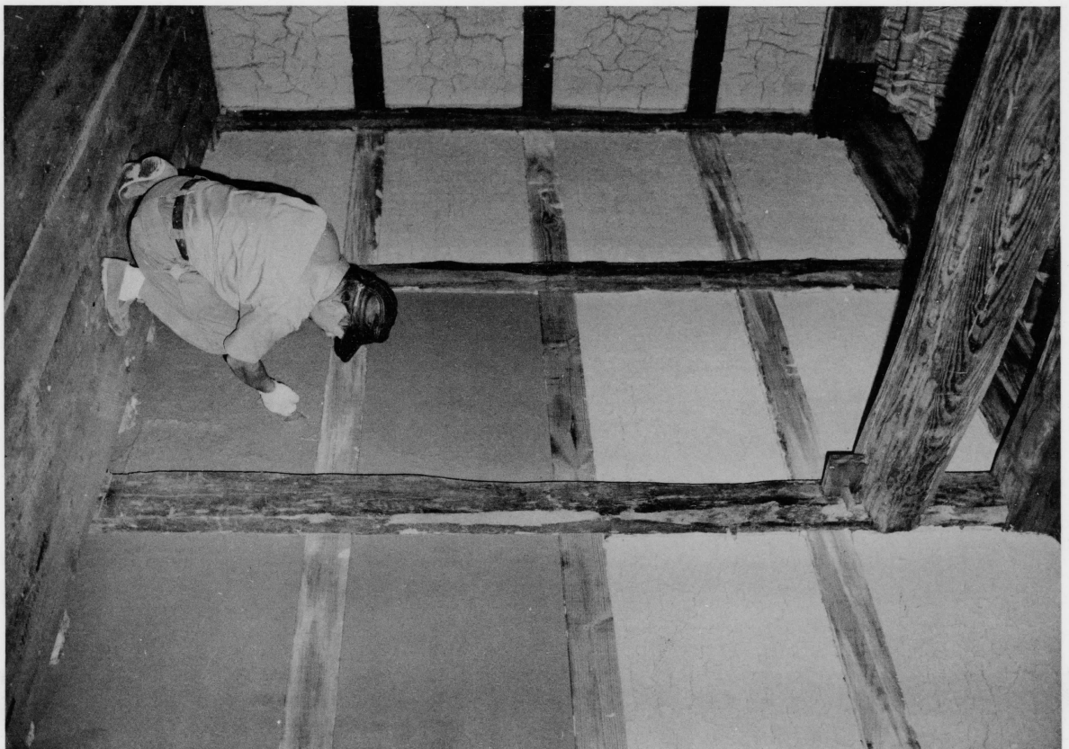
69 壁工事 (中塗り)
