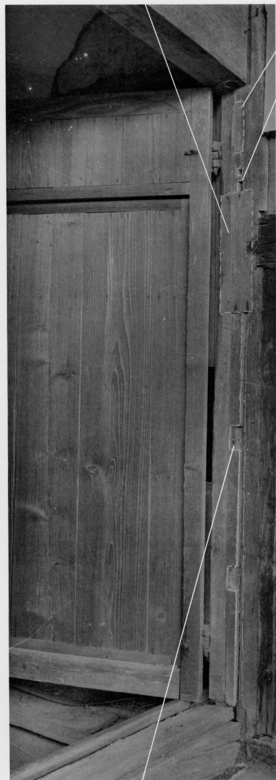
板壁の板溝及び胴縁穴
