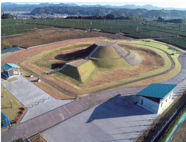
令和5年整備工事完成 南西から
