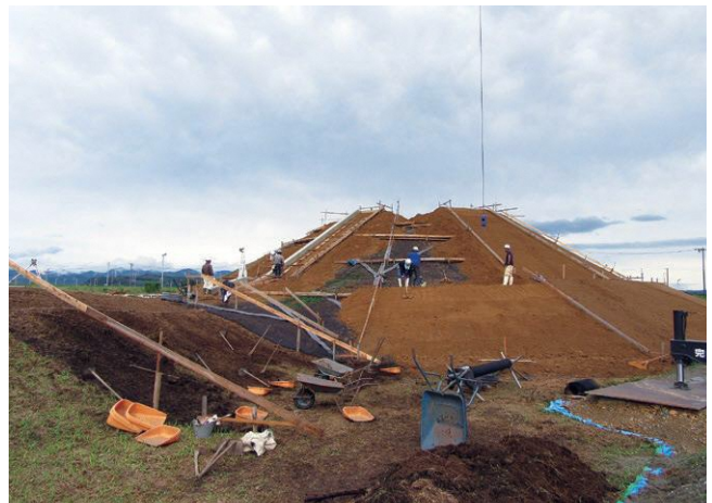
平成30年墳丘盛土工事の様子
