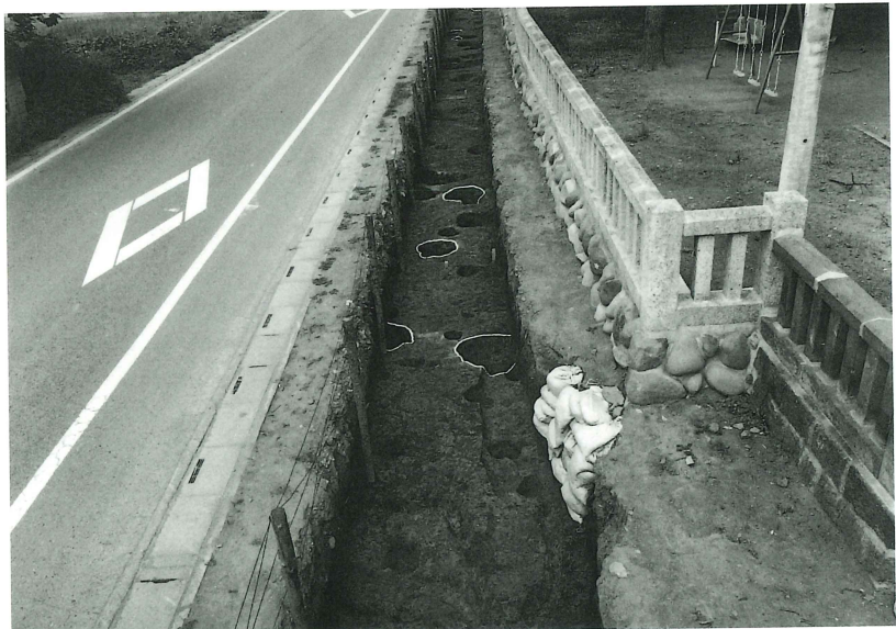
C区全景2(東から)
