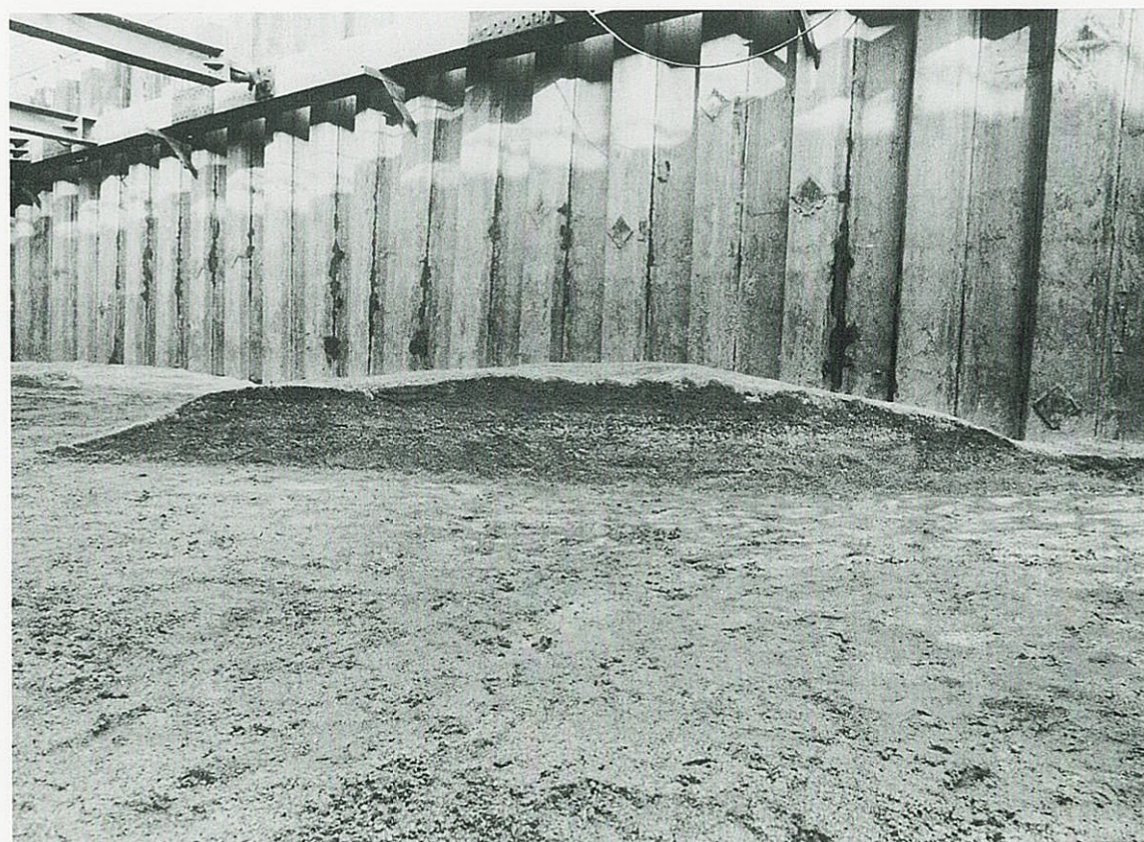
同上 断面（西から）
