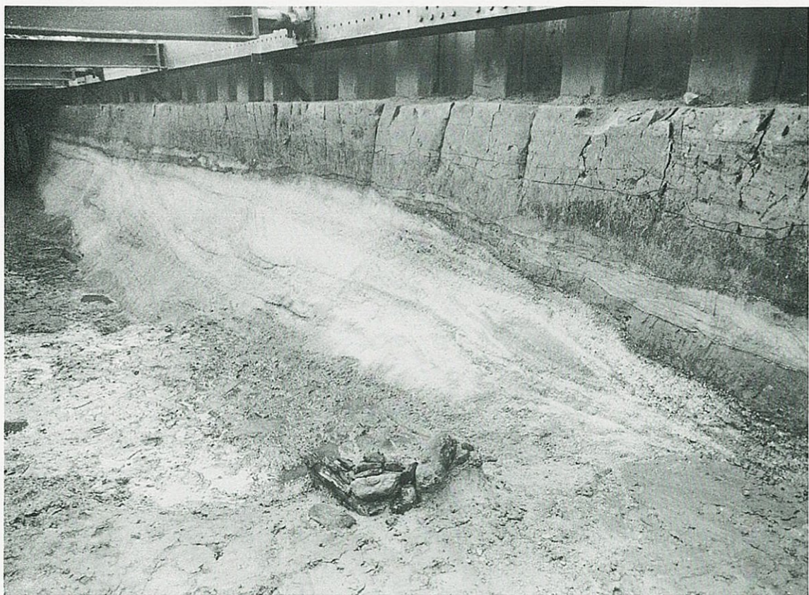
同上断面 (北東から)
