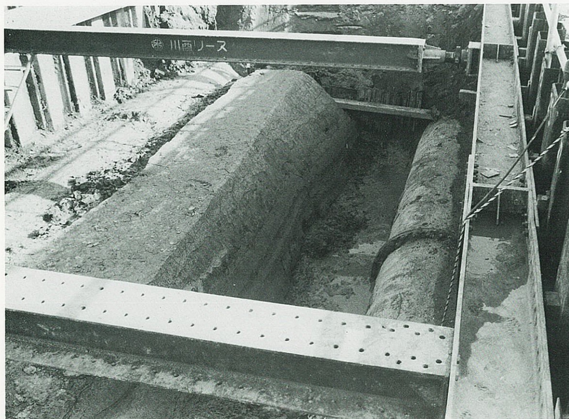
18区 工業用水管の間の残存部（北から）
