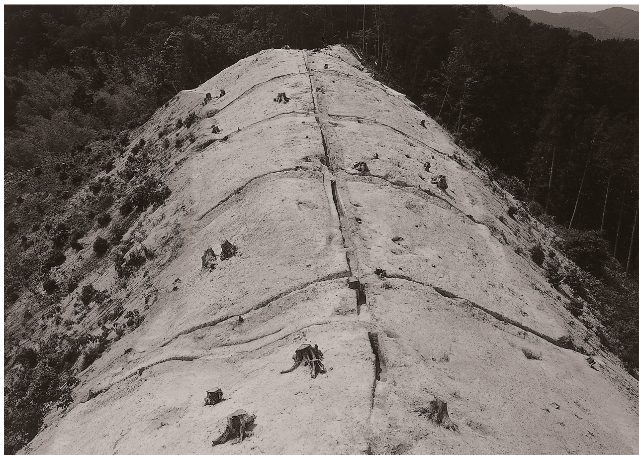
(2) A地区全景（北より）
