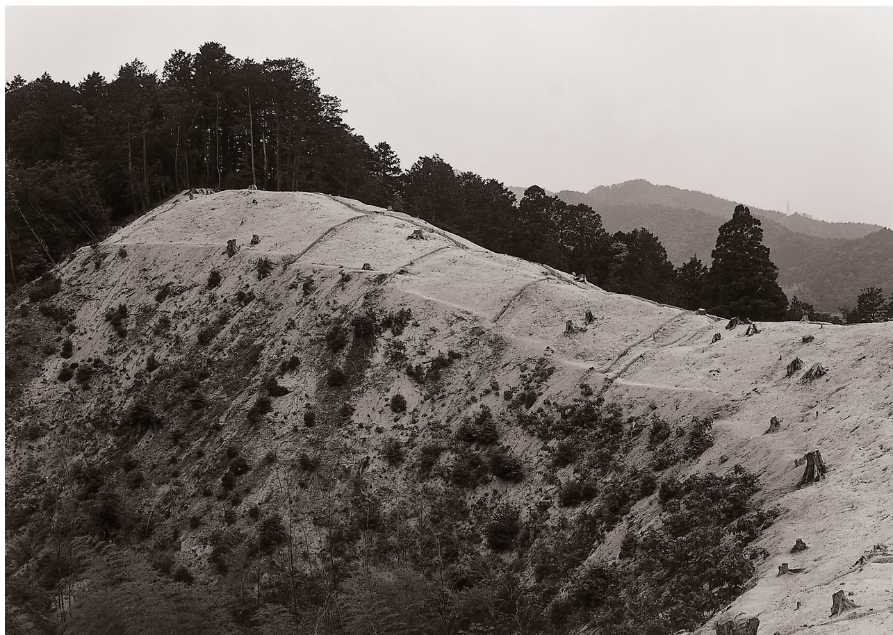
(1) A地区全景（北東より）
