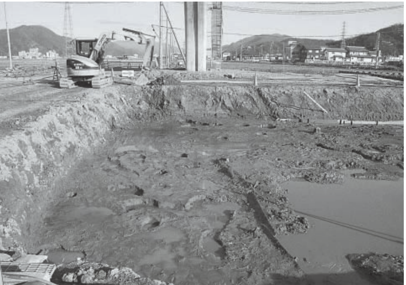
(2) 立会2区全景 (西より)
