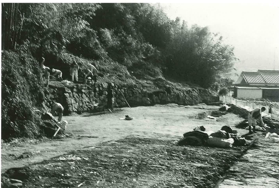
田井ヶ迫地区 石垣除去作業
