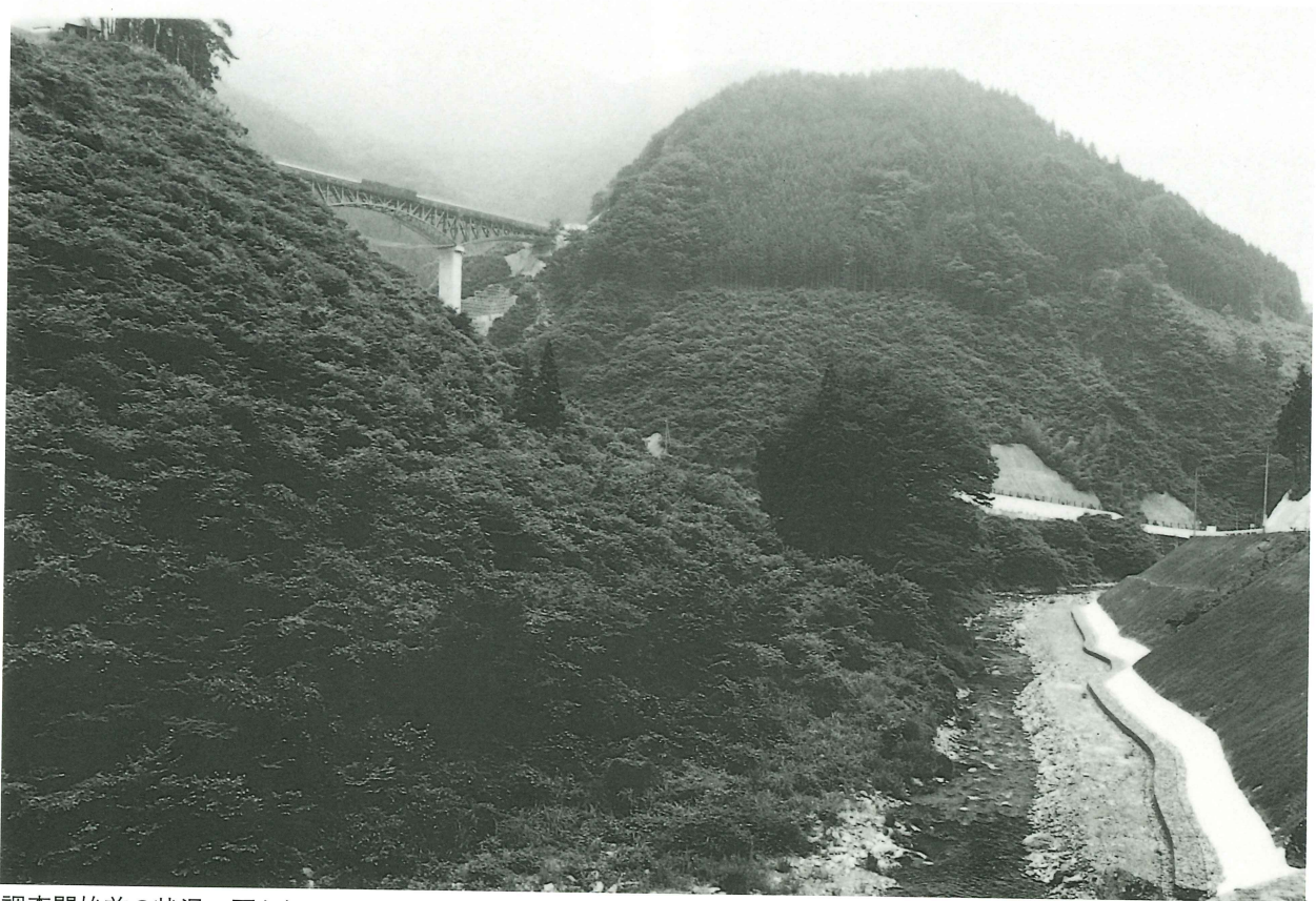
調査開始前の状況 西から
