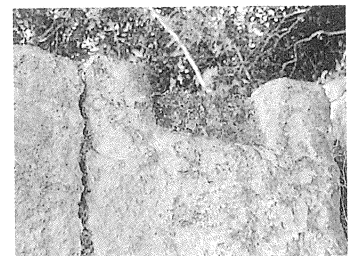
橋を架けたと見られる切り込み
