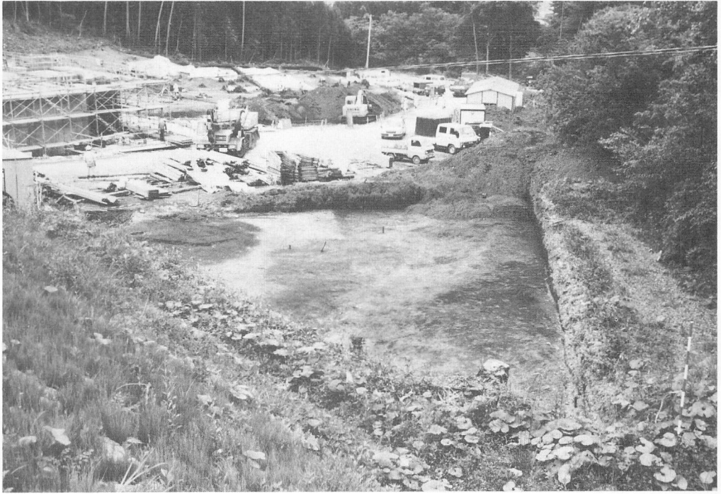
調査後近景（南西から）
