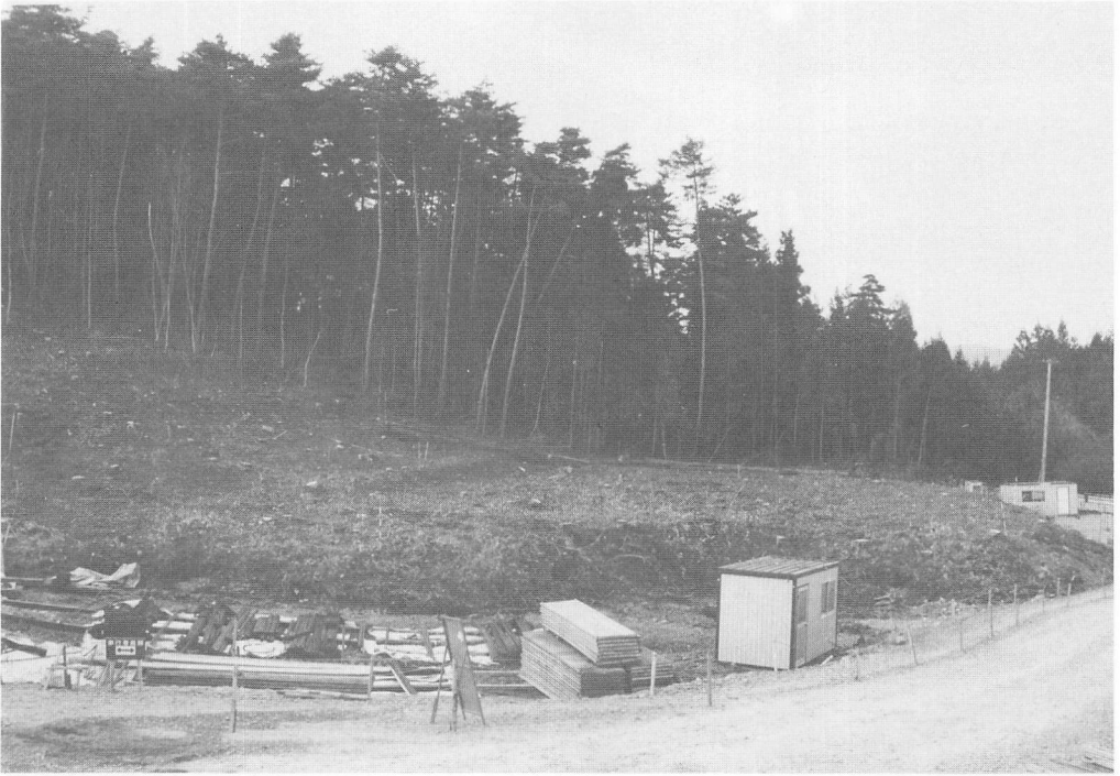
調査前近景（南から）
