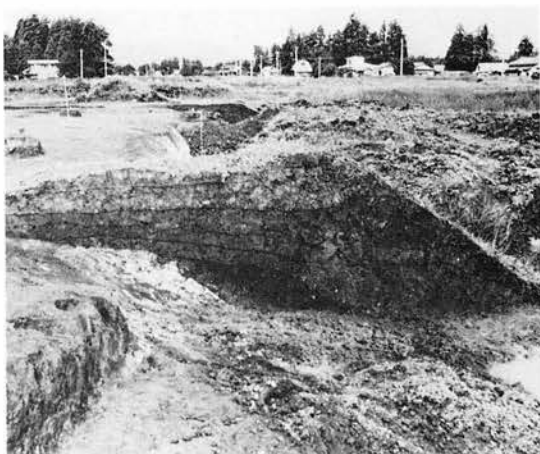
西館南北ベルト 北端部
