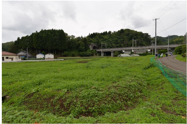
②. 着手前状況 (南東から)
