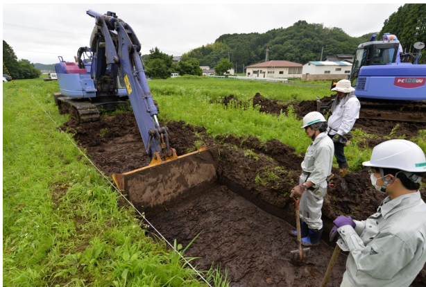
③. 1区掘削風景 (北西から)
