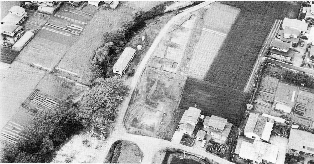
南調査区全景空中写真
