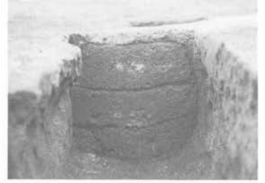
第2カマド煙道断面
